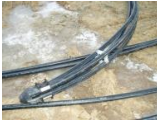
Endstück (Fuß) einer Doppel-U-Erdwärmesonde
