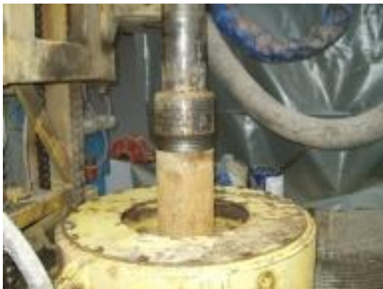
Zwischenschritt Bohrung: Einbau einer Verrohrung
